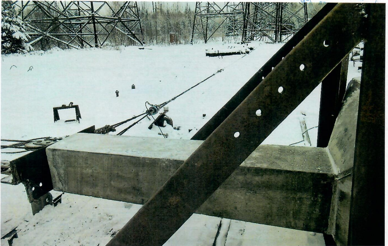
Рисунок 5 – Испытание фундамента Ф2-2
